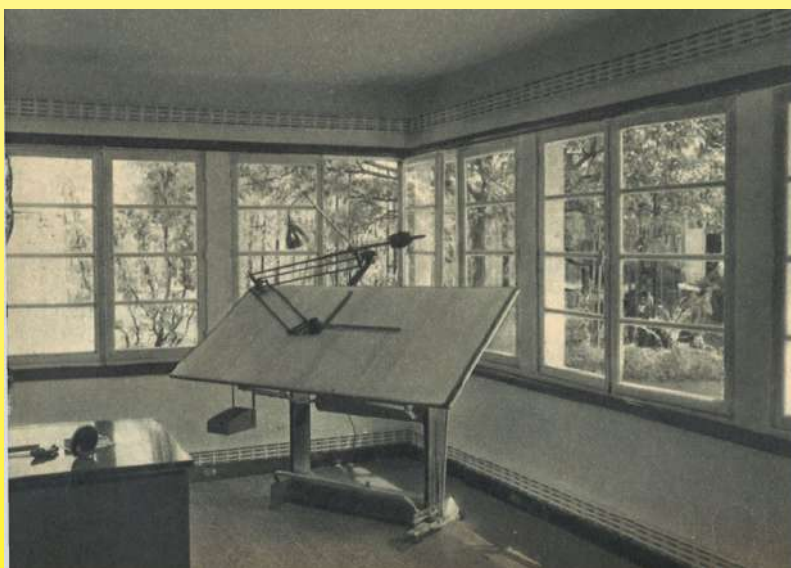
由 RAS 公司生产的 Rubancalor 加热带, 不仅仅可以围绕着天花板, 也可以围绕着墙基 (1958 年, Rambert, Le chauffage, Ultimheat 博物馆)
