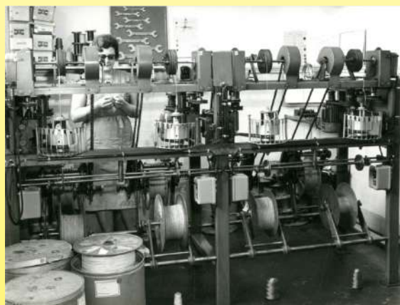
约 1960 年，用在电毛毯的发热丝 Guipage 车间（Ultimheat 博物馆）
